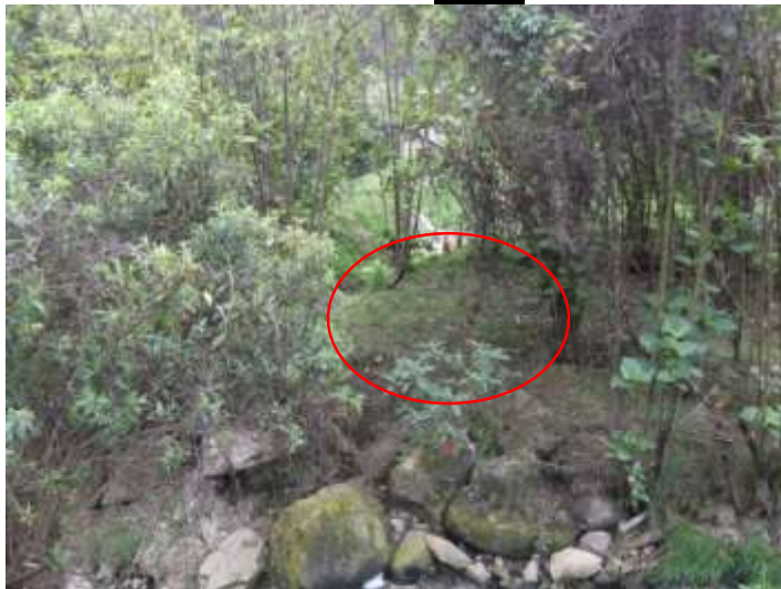
Foto 3. Disipador de energía existente en la quebrada El Pilar
