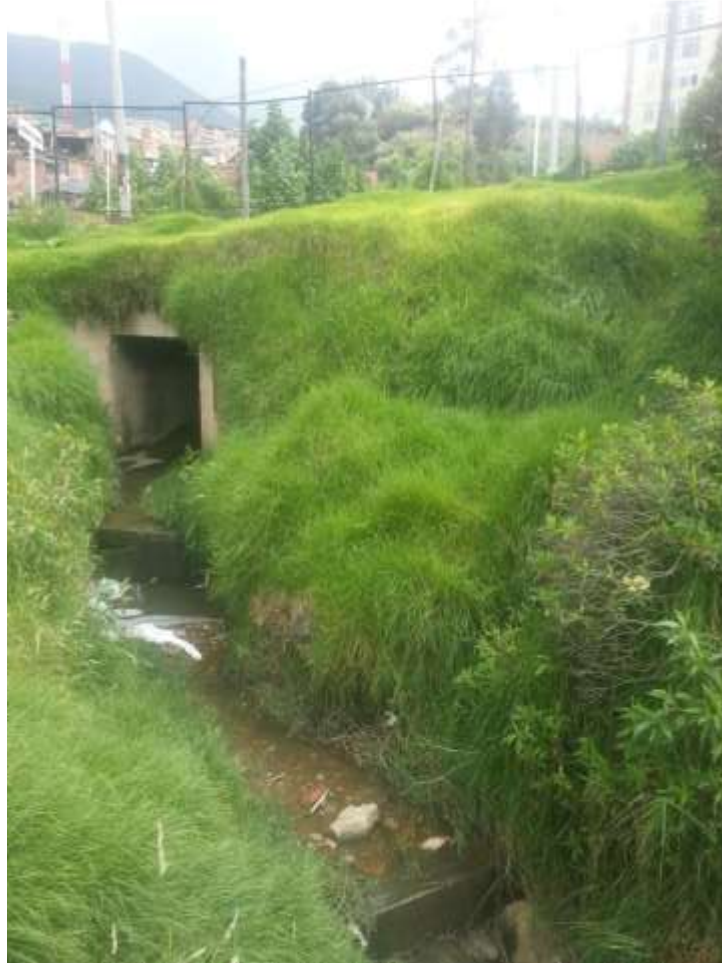
Fotografía 1. Punto de intervención de la quebrada El Pilar. Box coulvert y disipadores de energía existentes.
