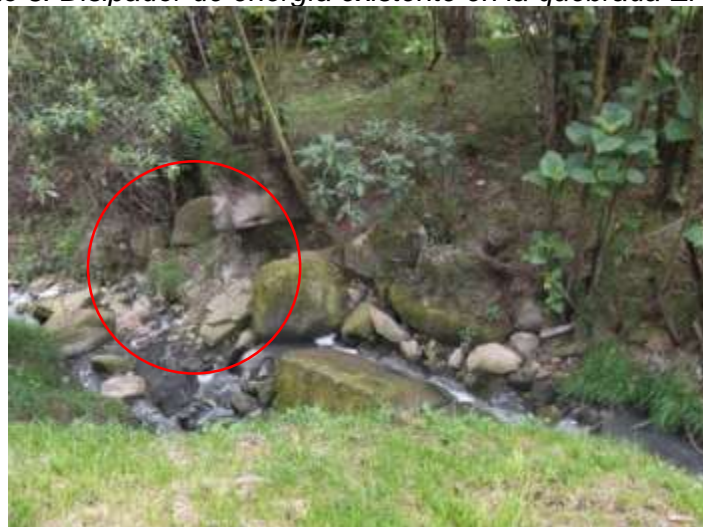
Foto 4. Descole Quebrada el Pilar
